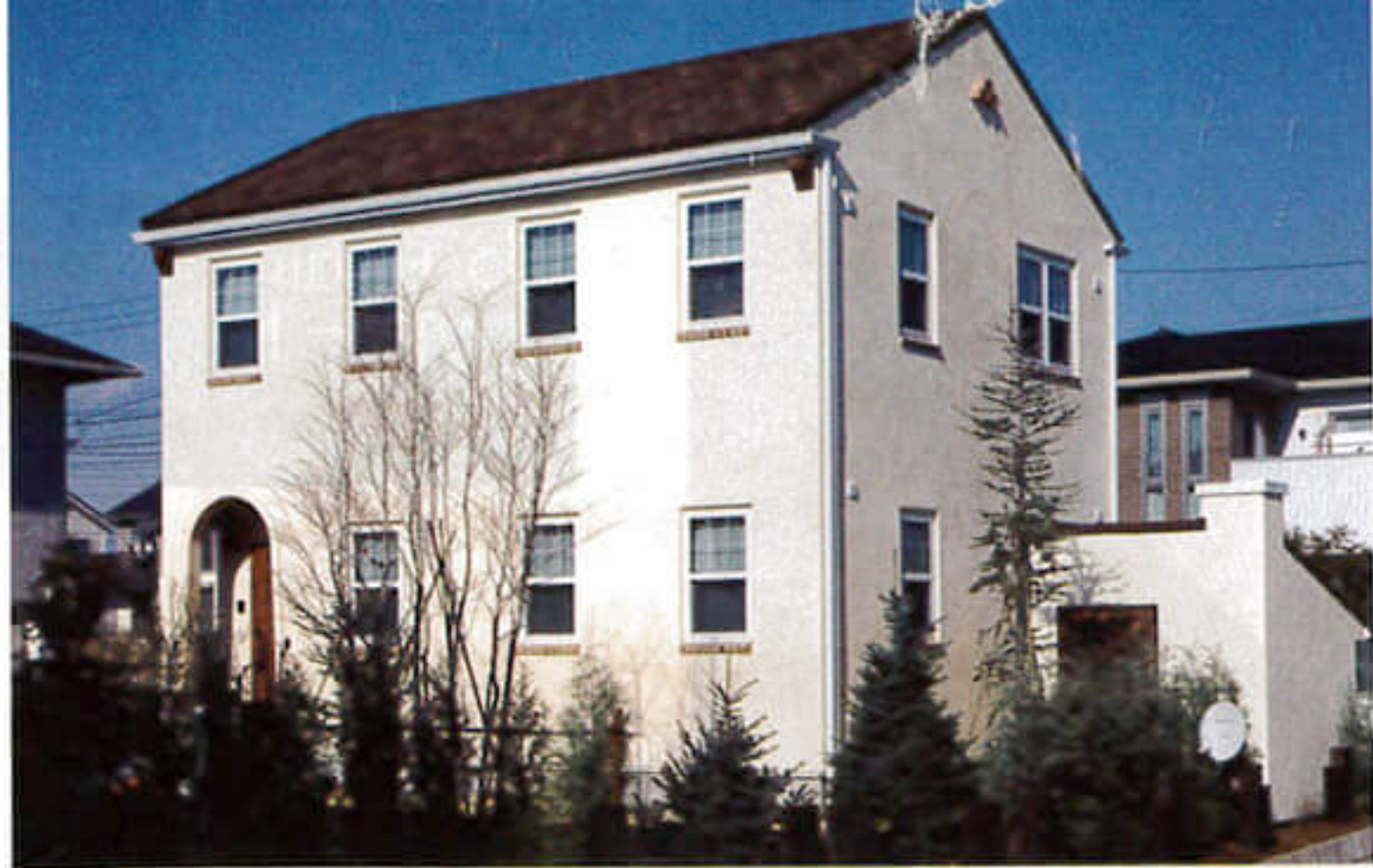
⑥職人の手仕事による手塗りの外壁と瓦調の屋根が美しいラ・プロヴァンスの外観
